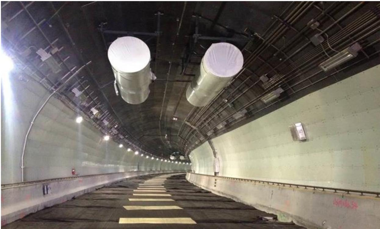
*Turbinas para refrescar el Túnel de Miami, fotodurante la construcción (fuente: portofmiamitunnel.com)*
